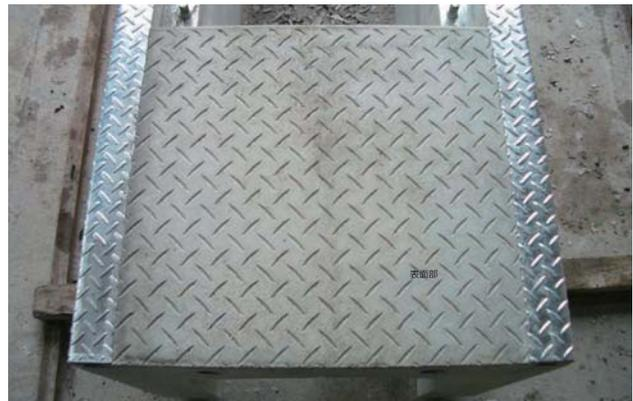
雨天時の歩行者や自転車の転倒を防止するために、横断製品蓋掛け上部の保護金具に滑り止め加工を施せます。歩行者等が多い場所にお勧め致します。
