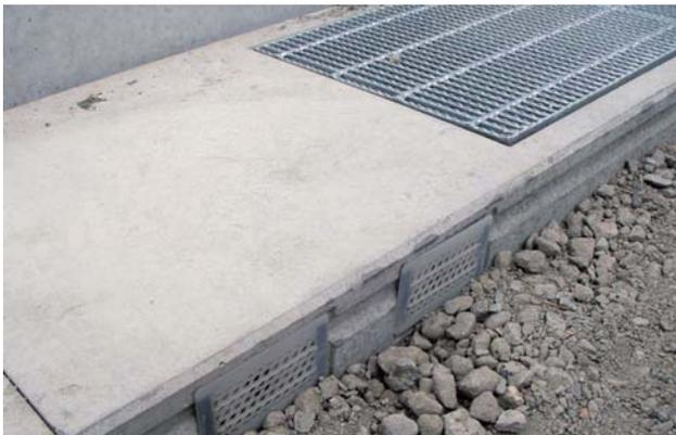
可変側溝の側面に、排水性舗装からの排水を取り込む孔が開いた製品です。排水性舗装道路の側溝としてご利用頂けます。
